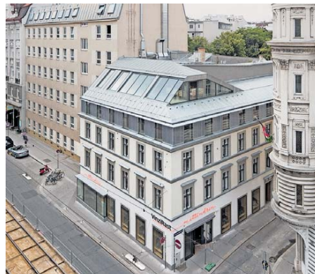
Das Haus schiebt sich forsch auf den Bürgersteig. Der kürzeste Weg führt durch das Lokal im Erdgeschoss. Das ist im Sinne des Projekts. FOTO: SEBASTIAN SCHUBERT
